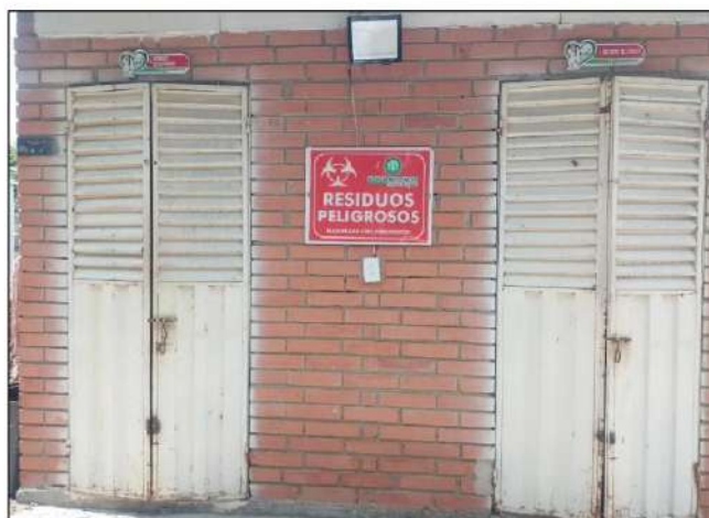
Imagen 2. Almacén de residuos peligrosos Hospital Local Municipio de Los Patios
